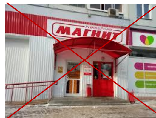
Отделка фасада профилированным металлическим листом
