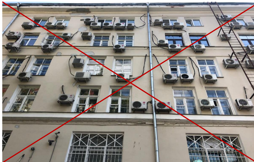
Пример НЕправильного размещения кондиционеров на внутридвором фасаде
